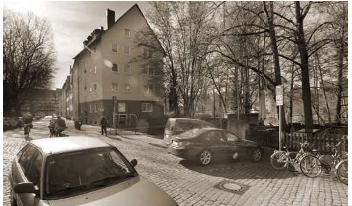
Abb. 71: Aktuelle Situation zwischen Hallertor, Nägeleinsplatz und Maxplatz
